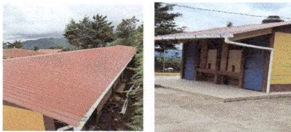
Foto 5: Sustitución de canal de pvc
