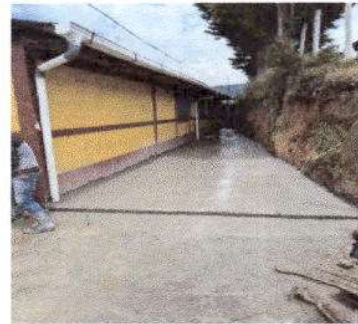
Foto 4: Reparación de piso de torta de concreto
