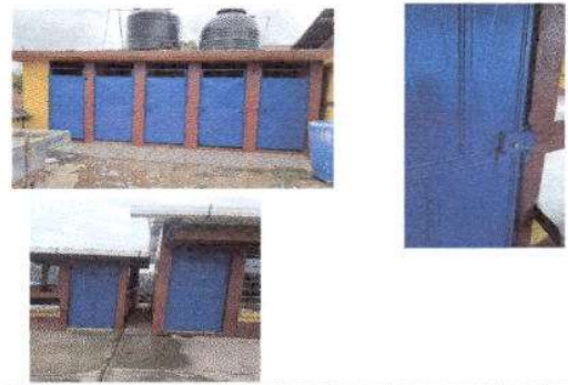
Foto 2: Mantenimiento a estructura (lijado y aplicación de pintura a puertas de aulas y baños ) y sustitución de una chapa.
